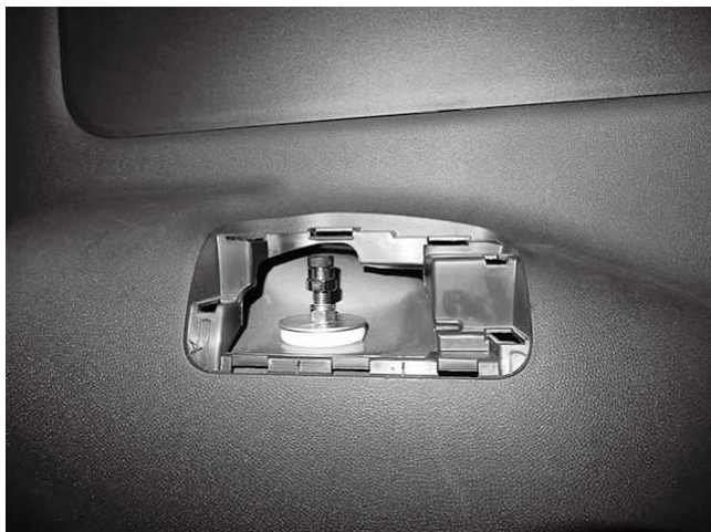
トップナット締め付け状態
