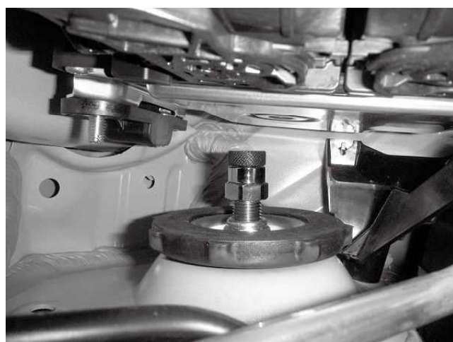
トップナット締め付け状態
