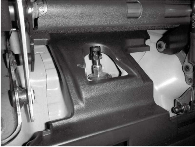
トップナット締め付け状態
