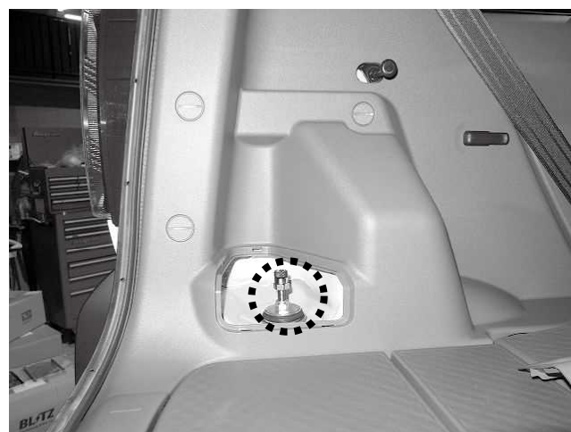
トップナット締め付け状態
