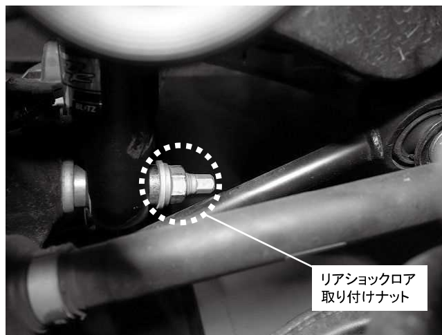
リアショックロア取り付けナット1カ所締め付け 締め付けトルク: 125\text{N}\cdot\text{m} ( 12.7\text{kgf}\cdot\text{m} ) ※リアショックを伸ばすと、ロアアームとボルトが近くなります リアショック調整時は、干渉していないか必ず確認してください ※写真は基準車高(寸法)の0G時状態です
