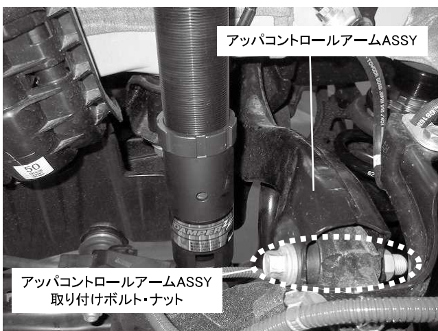
リアショック取り付けの際アッパコントロールアームASSYを 一度切り離すことで、作業がしやすいです
