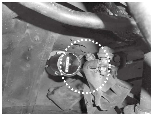
リザーバータンクと スタビライザー取り付け部分との干渉に 注意してください。
