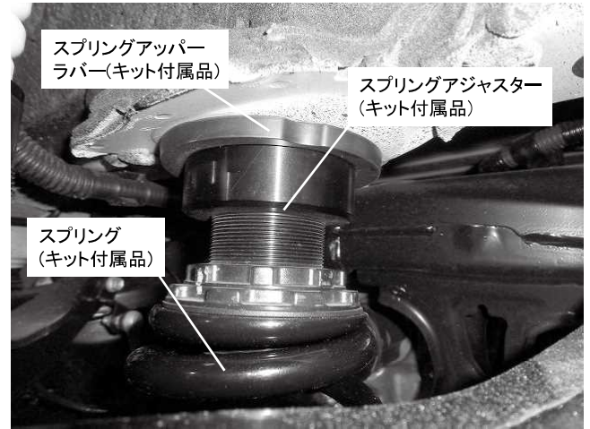
リアスプリング取り付け状態(アッパー側) ※キット付属品のスプリングアッパーラバーが しっかりはまっているか確認してください
