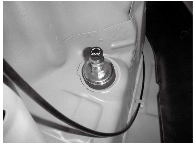
トップナット締め付け状態
